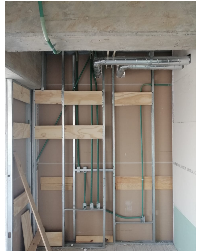
Ducteria Eléctrica Muros (Nivel 19)
