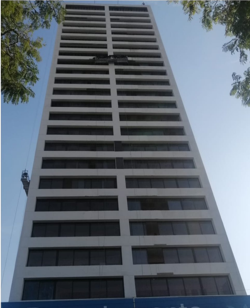
Fachada Norte: Aplanados en Fachada: Detallando
