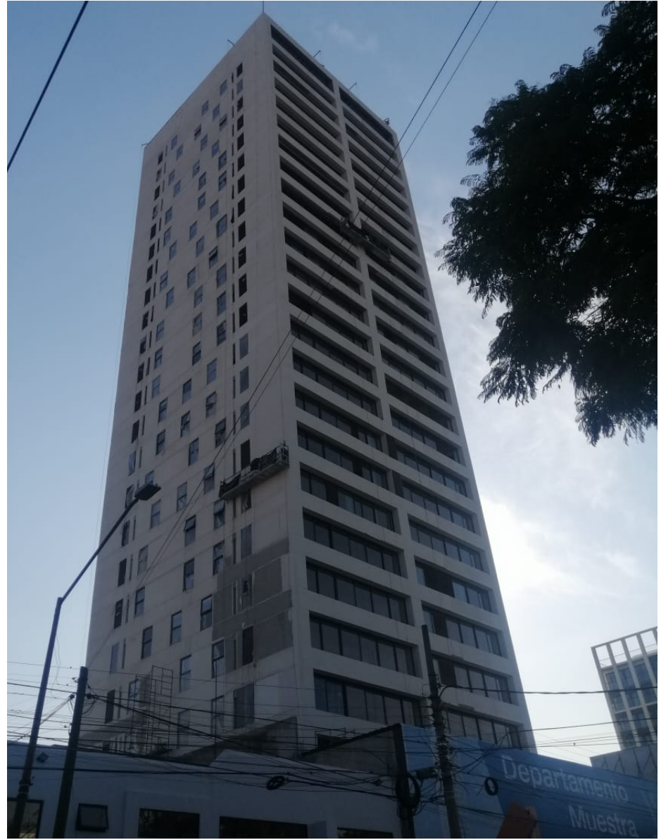
Fachada Oriente: Aplanados en Fachada: Detallando
