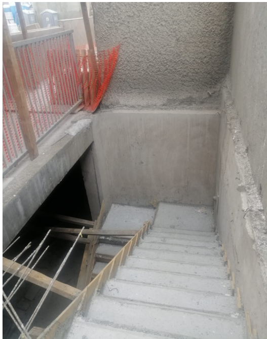
Escalera a S ótano 1
