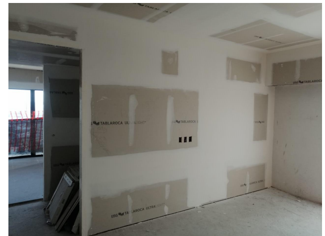
Pasta en Muros y Plafones (Nivel 15)
