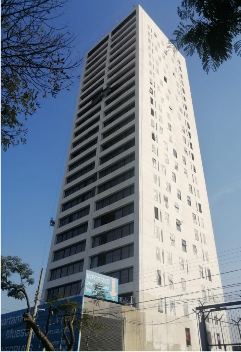
Fachada Poniente: Pintura en Fachada: Finalizado
