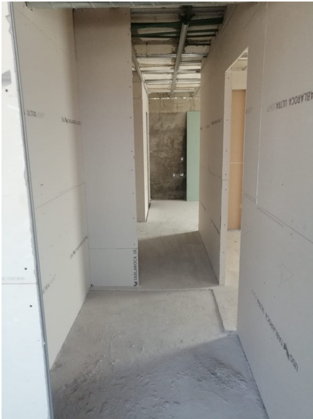
Muros de Tablaroca (Nivel 23)
