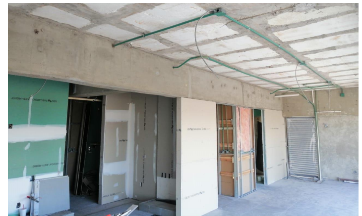
Cableado (Disparos) (Nivel 15)
