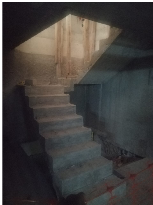
Escalera Sótano 2 y 3
