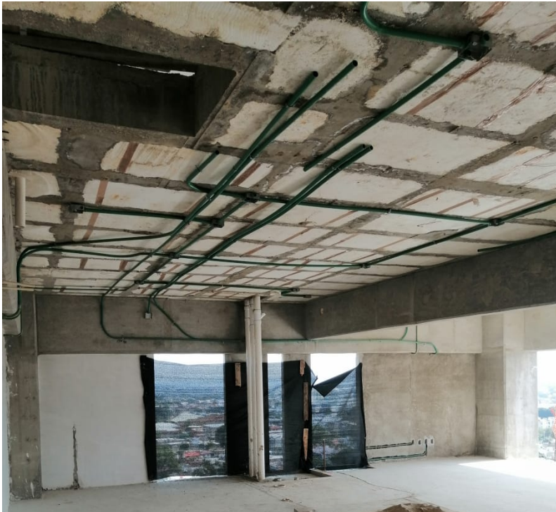
Instalaciones Eléctricas Losa Nivel 13
