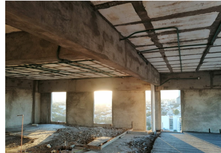
Instalaciones Eléctricas Losa Nivel 20
