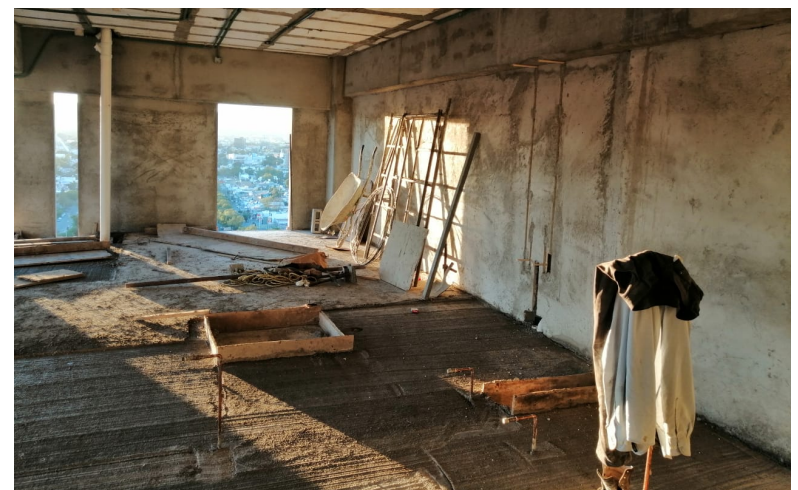
Instalación Gas Nivel 20
