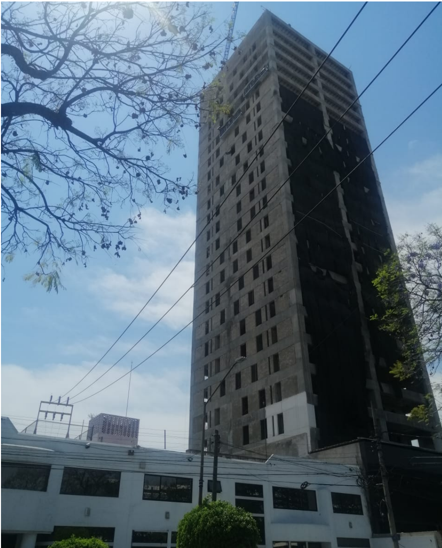
Fachada Oriente (nivel 24)
