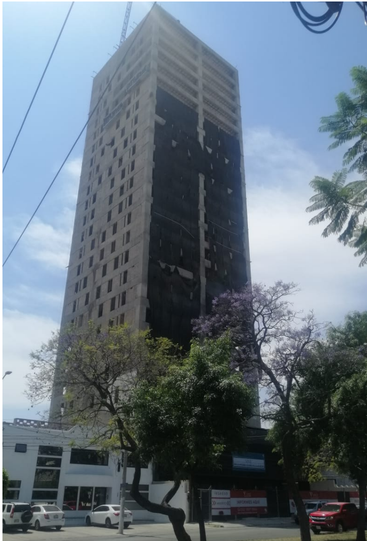
Fachada Norte (nivel 25 Azotea)
