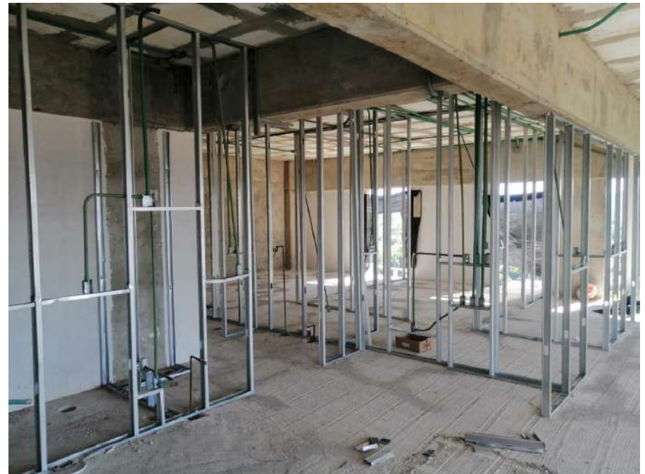
Inst. Eléctricas en Muro 17
