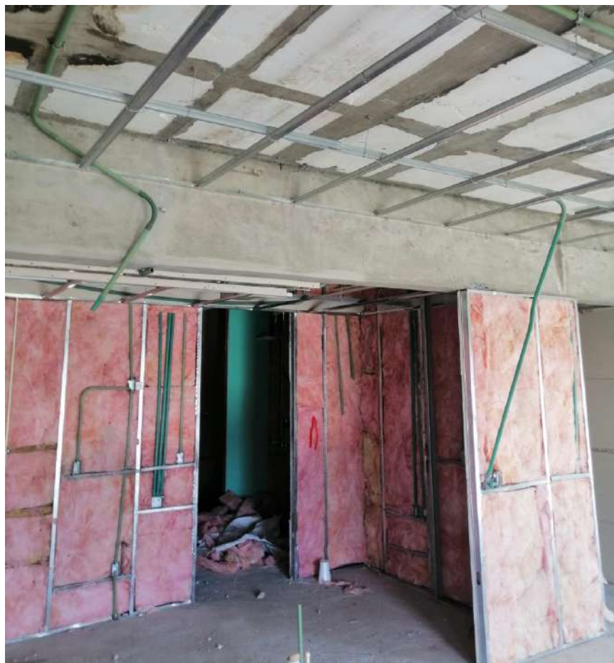
Muro de Tablaroca Nivel 6
