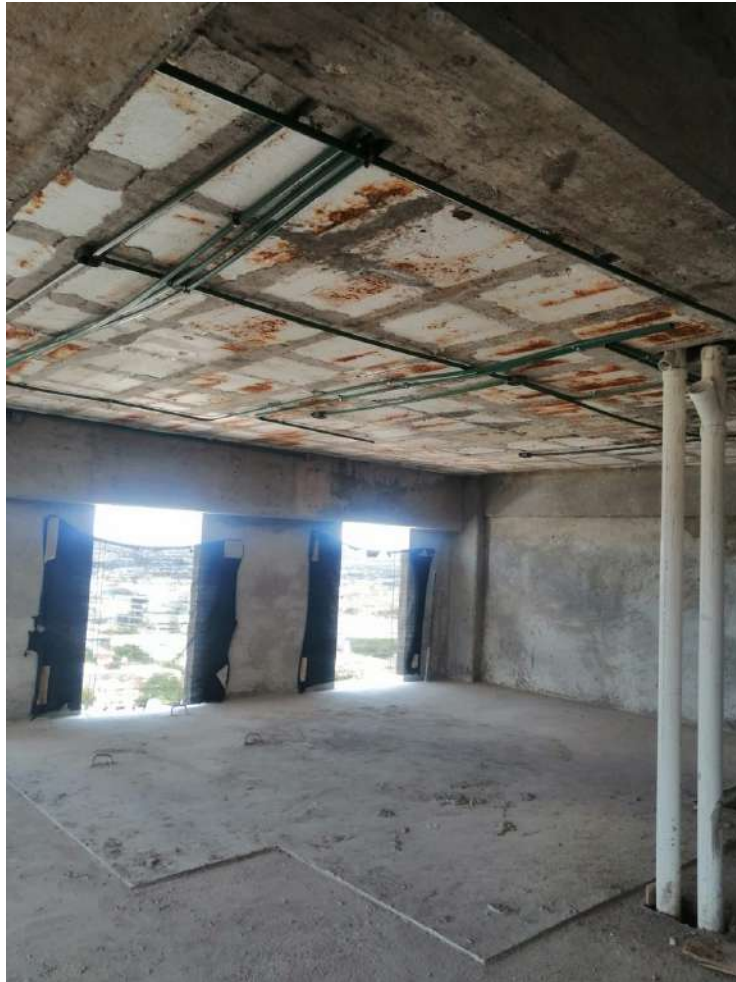
Inst. Eléctricas en Losa Nivel 22
