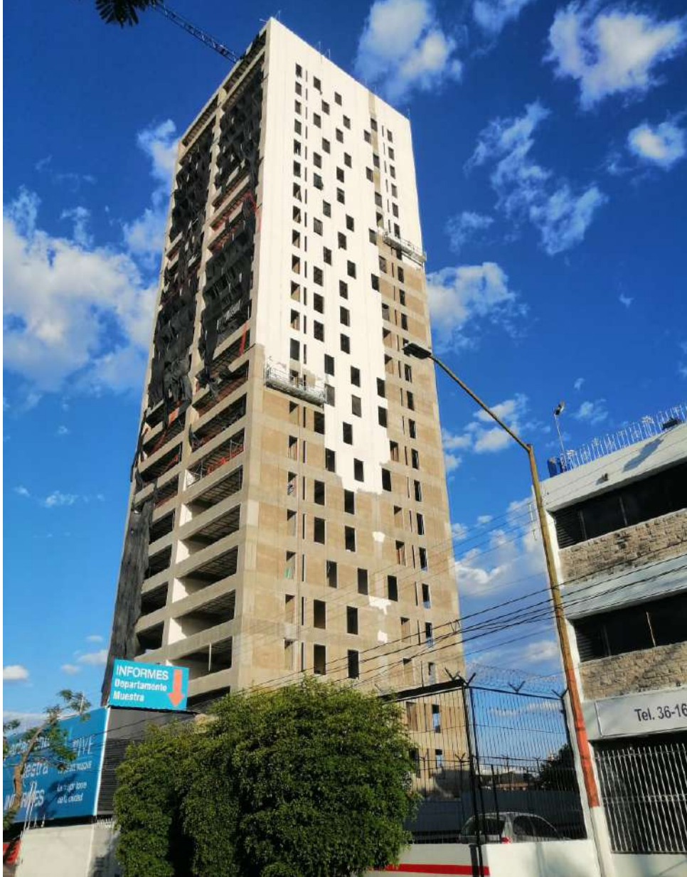
Fachada Poniente: Aplanados en Fachada: 50% Avance
