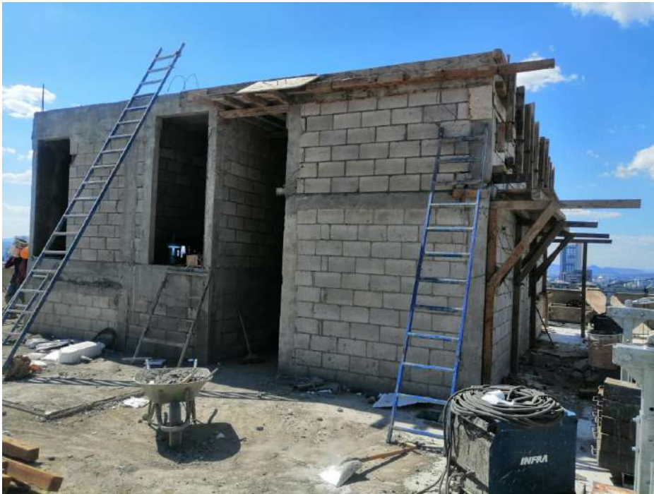
Cuartos de Servicio y Máquinas Azotea
