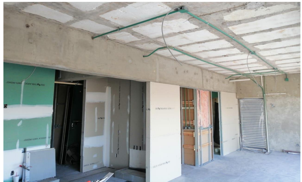
Cableado (Disparos) (Nivel 15)
