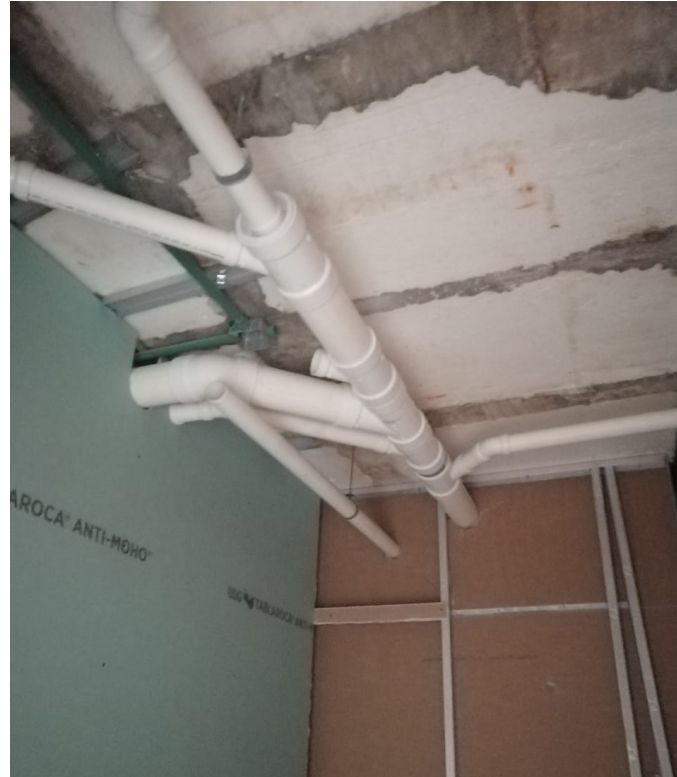
Inst. Sanitarias (Nivel 21)
