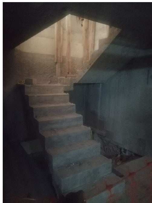
Escalera Sótano 2 y 3
