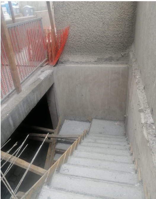
Escalera a S ótano 1
