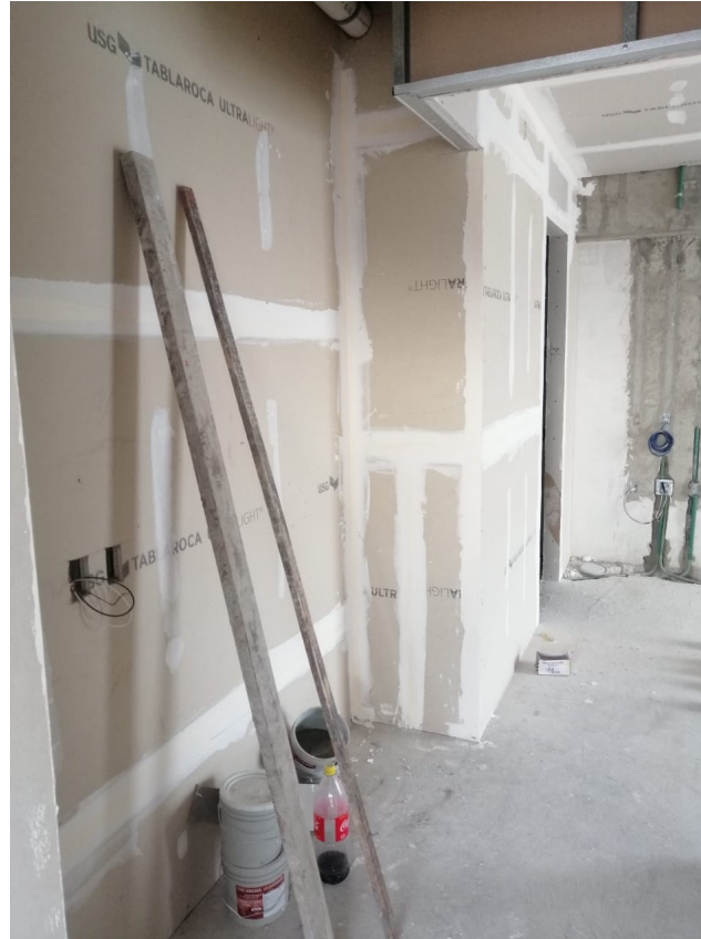
Pasta en Muros y Plafones (Nivel 15)
