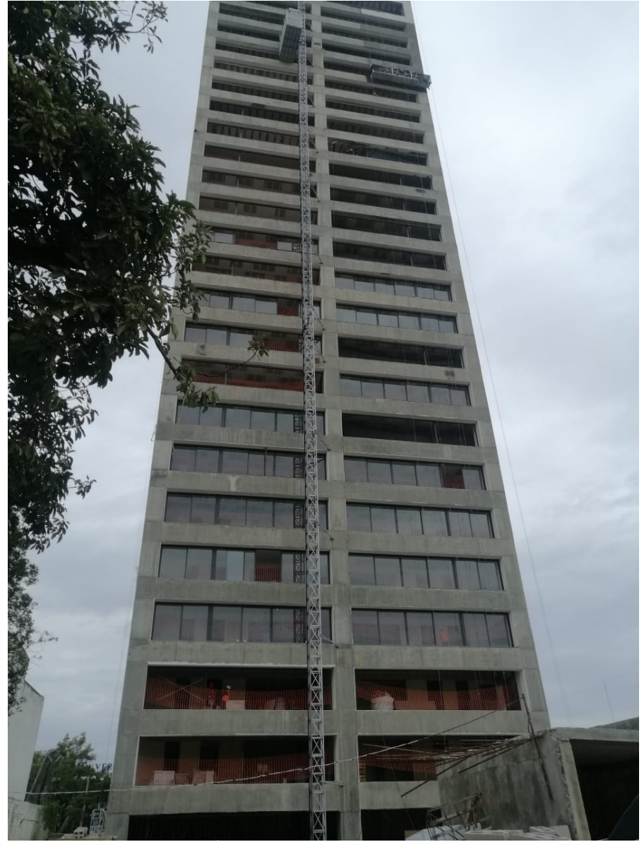
Fachada Sur Aplanados en Fachada: 7% Avance
