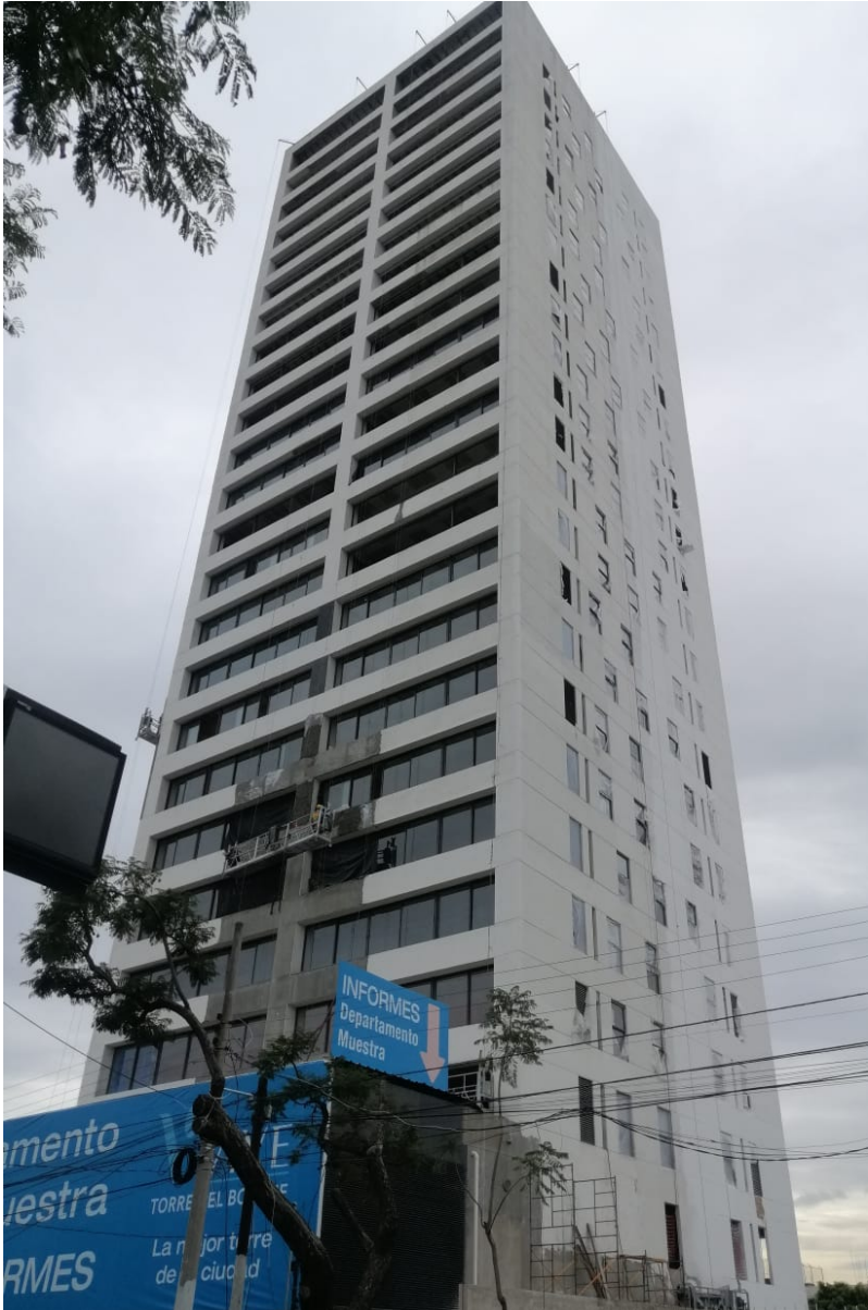
Fachada Poniente: Pintura en Fachada: 50% Avance
