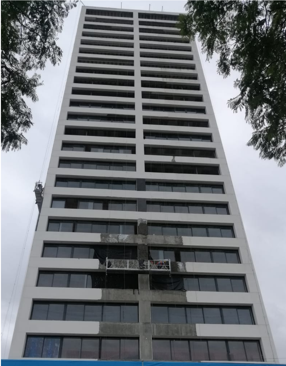
Fachada Norte: Aplanados en Fachada: 90% Avance
