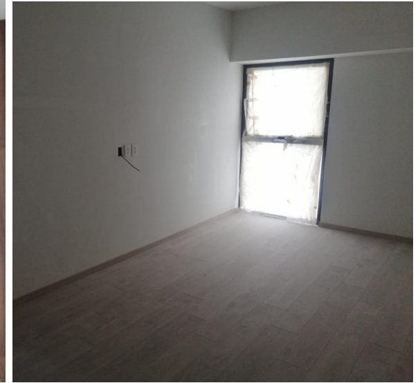
Piso Laminado (Nivel 3)
