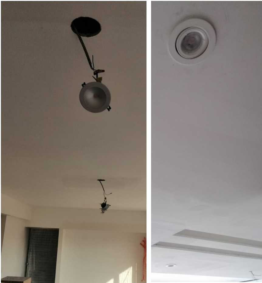
Inst. Luminarias (Nivel 03)
