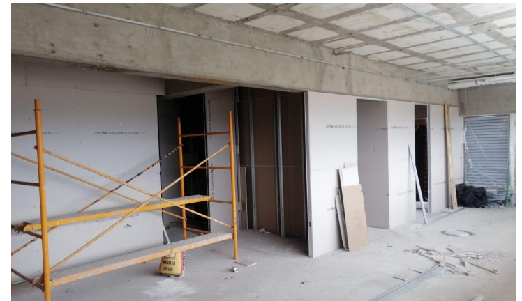
Muros de Tablaroca (Nivel 23)
