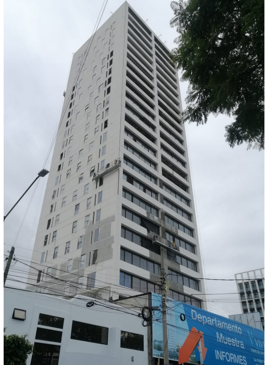
Fachada Oriente: Aplanados en Fachada: Detallando
