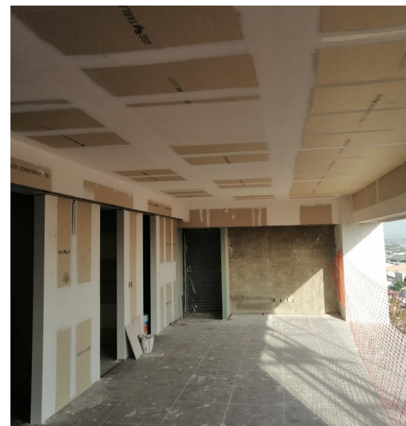
Nivel 13 Colocación de Pasta en Muro y Plafón
