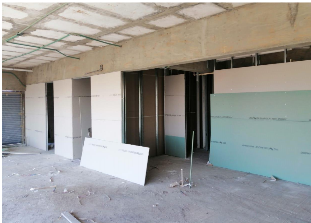
Nivel 19 Tablaroca en Muro
