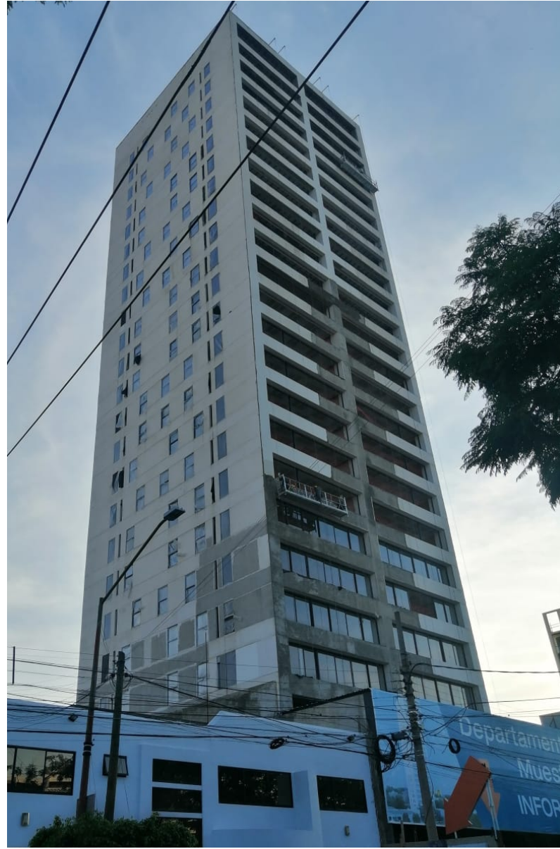
Fachada Oriente: Aplanados en Fachada: Detallando
