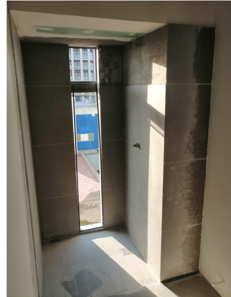
Nivel 4 Porcelanato en Baños
