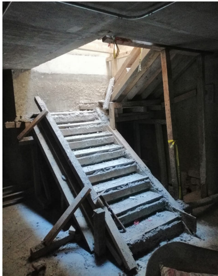
Escalera Sótano 2 y 3
