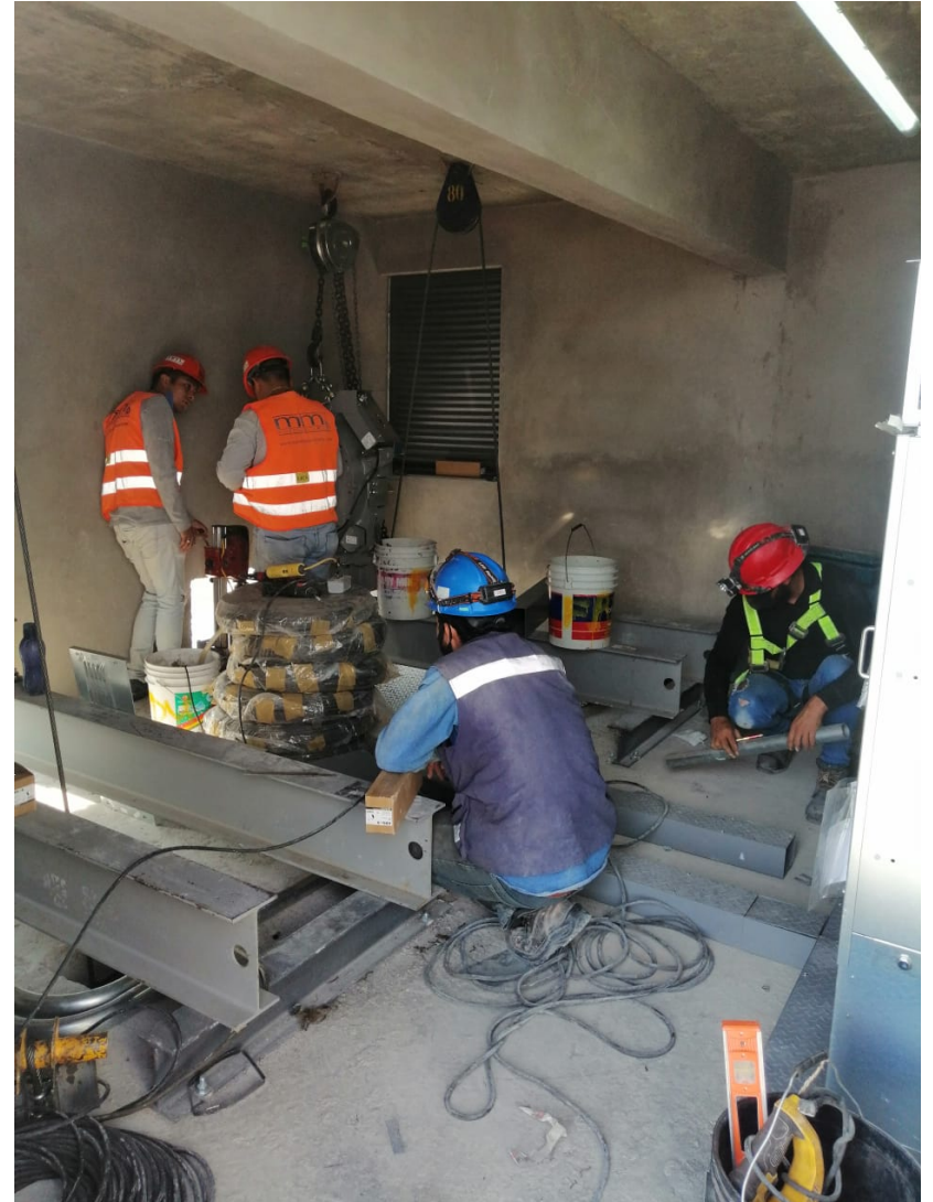
Trabajos en ductos y tableros en el cuarto de máquinas
