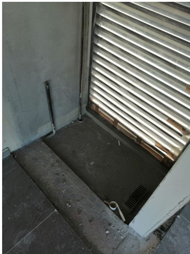
Nivel 04 Impermeabilizante Regadera
