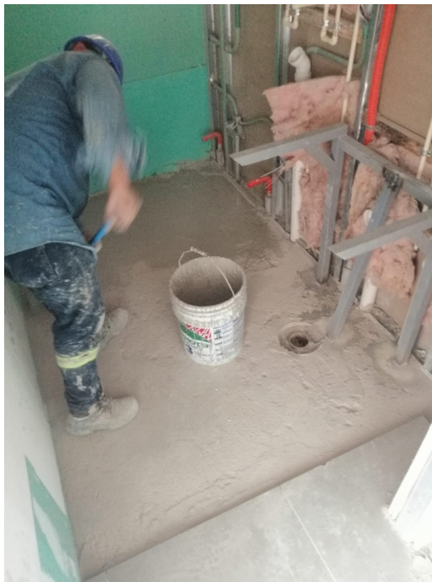
Nivel 06 Impermeabilizante Cuarto Lavado
