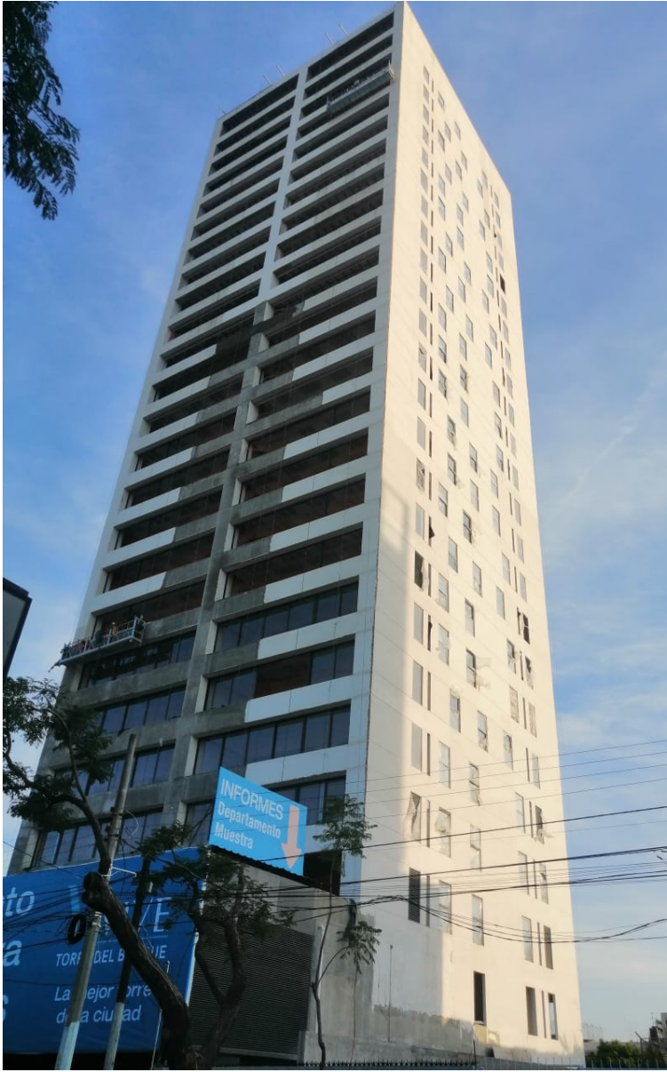
Fachada Poniente: Aplanados en Fachada: Detallando
