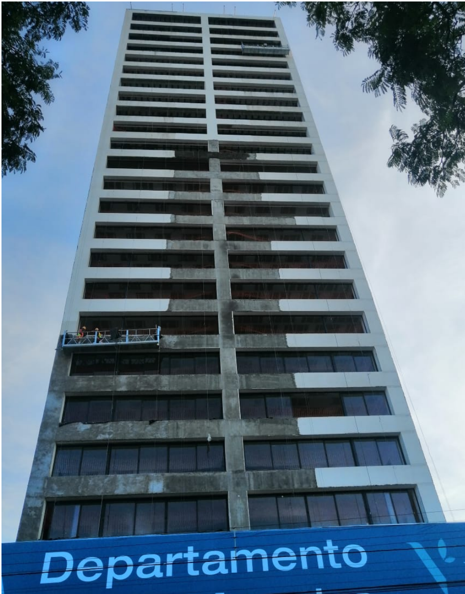
Fachada Norte: Aplanados en Fachada: 80% Avance
