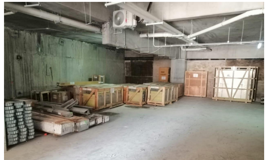
Elevador en Obra
