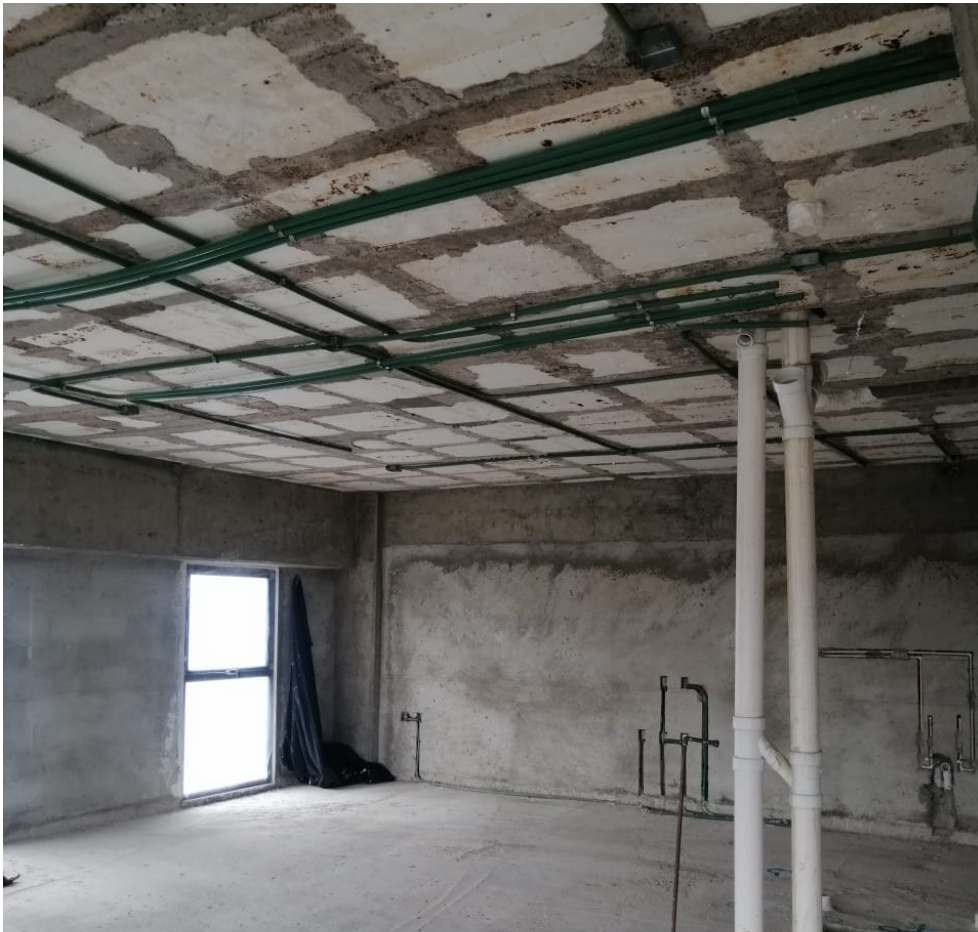
Nivel 20 Inst. Eléctricas en Losa
