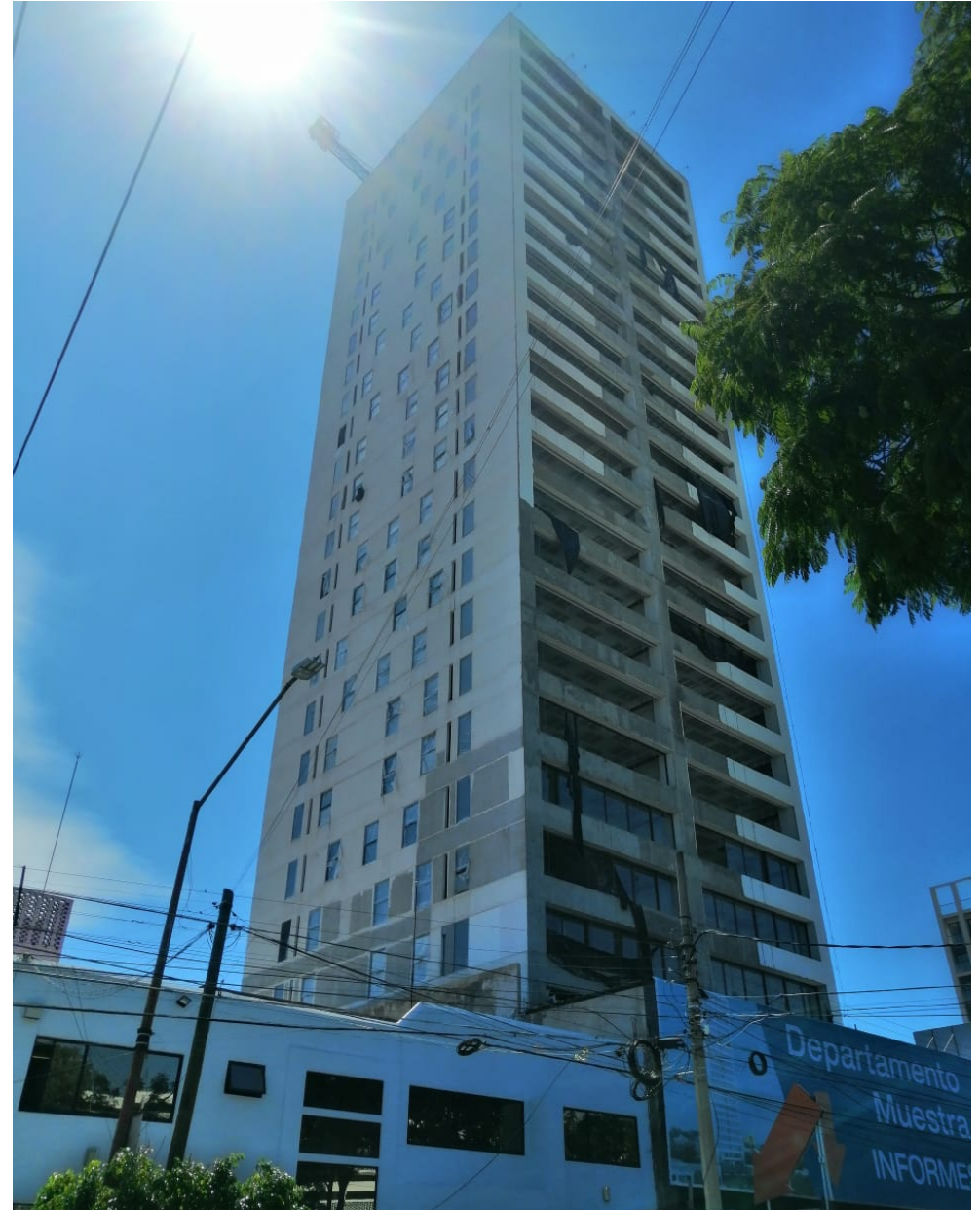
Fachada Oriente: Aplanados en Fachada: 90% Avance
