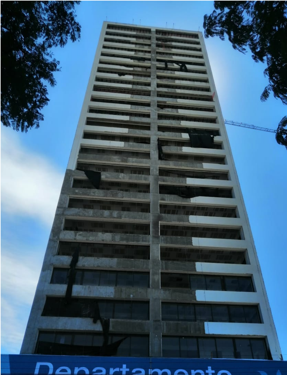
Fachada Norte: Aplanados en Fachada: 50% Avance
