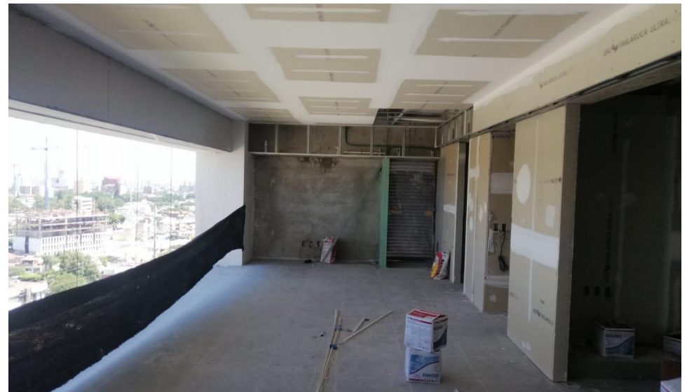
Nivel 12 Colocación de Pasta en Muro y Plafón
