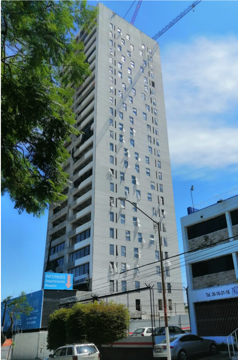
Fachada Poniente: Aplanados en Fachada: Detallando
