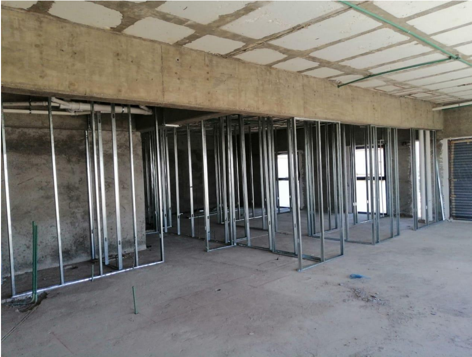
Nivel 21 Mestales (Soportes) en Muro
